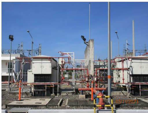
ภาพที่ 2-38 Sprinkler System
