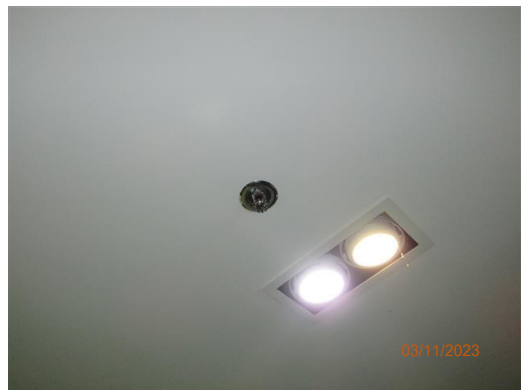
ภาพที่ 2-38 Sprinkler System
