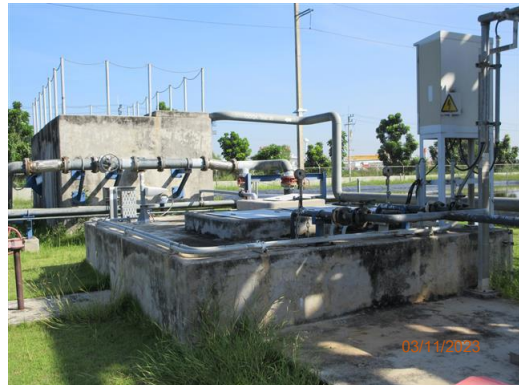
ภาพที่ 2-11 Oil Separator
